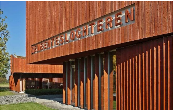
Figuur 18 Rustig en eenduidig gevelbeeld
