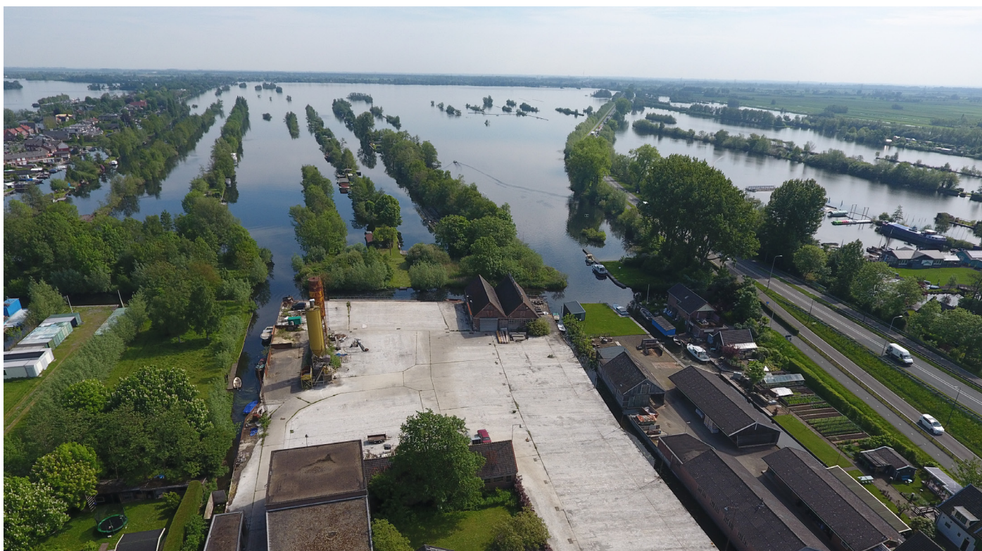
Huidige waterstructuur vanaf de Adelaar naar de plassen
