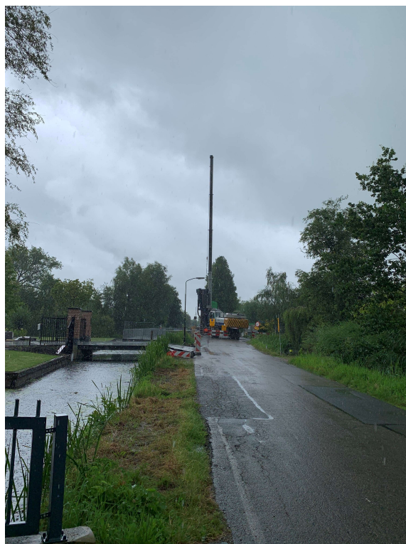
Het werk aan de nieuwe brug is in volle gang.
