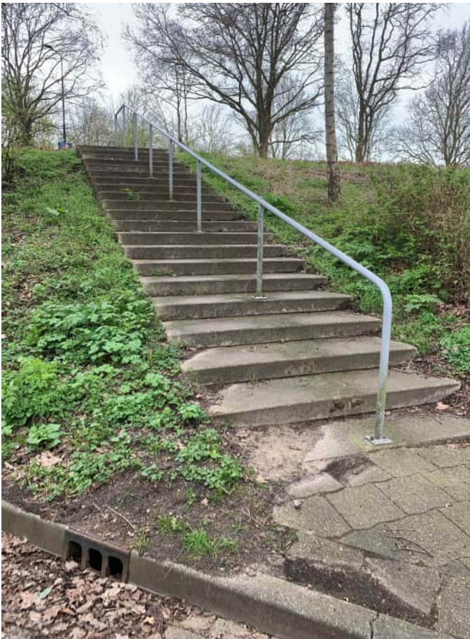
Huidige trap vanaf talud viaduct naar Willestee
